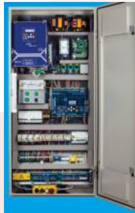
Assemblage Armoire Electrique 2016
